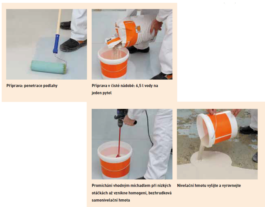
Obr. 11: Aplikace samonivelační stěrky [zdroj: http://www.fermacell.cz/ ]
