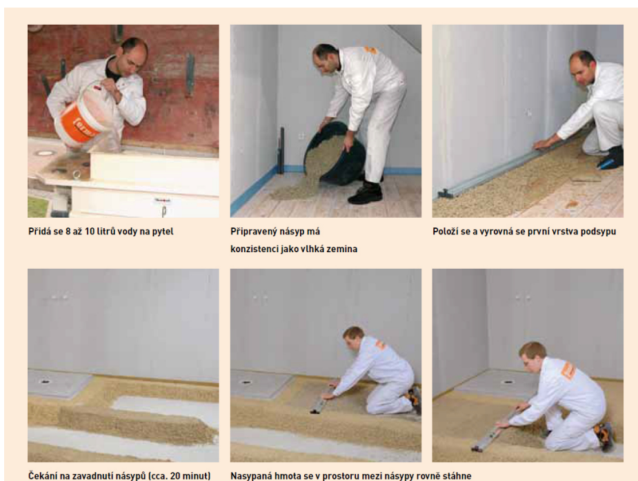
Obr. 13: Rychletuhnoucí podsyp Fermacell [zdroj: http://www.fermacell.cz/ ]
