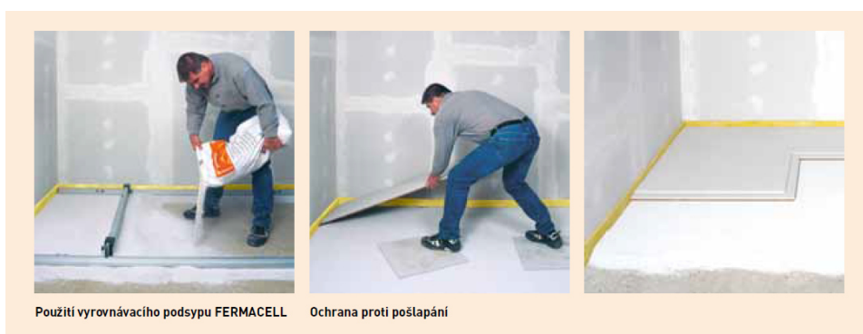
Obr. 12: Vyrovnávací podsyp Fermacell [zdroj: http://www.fermacell.cz/ ]
