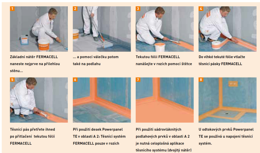
Obr. 16: Stěrková hydroizolace [zdroj: http://www.fermacell.cz/ ]
